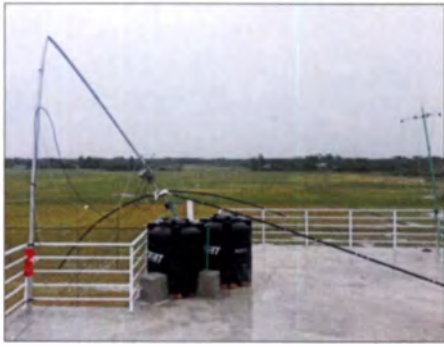
Starke Winde verursachten einen umgeknickten Mast, doch ließ sich der Schaden reparieren.
